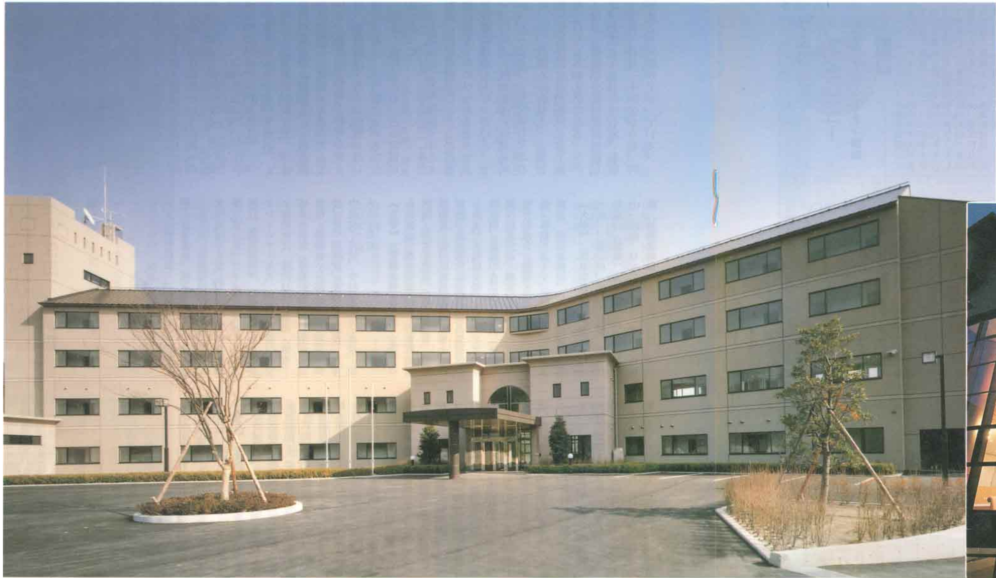
外観全景（北面）
