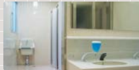
④ 本館1階～4階東側女子トイレ改修
