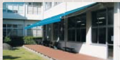
⑤ 第1学生ホール南側オーニングとデッキ(東1号館1階南)
