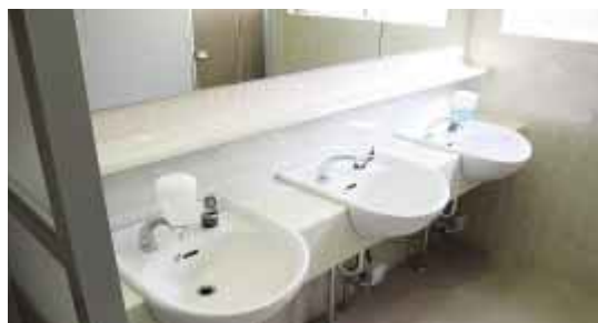
体育館トイレ（写真③）
