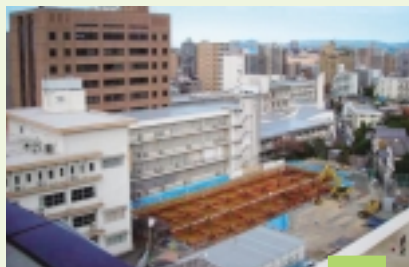
掘削中の地盤のくずれを防止させるためH鋼にて補強
