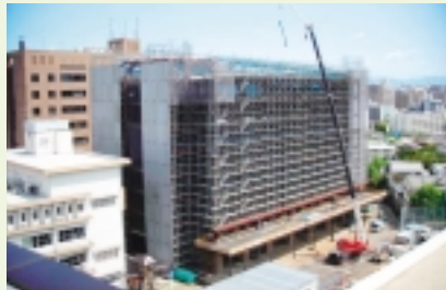
鉄骨組立完了
