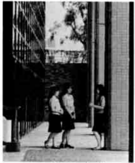
西1号館が完成
